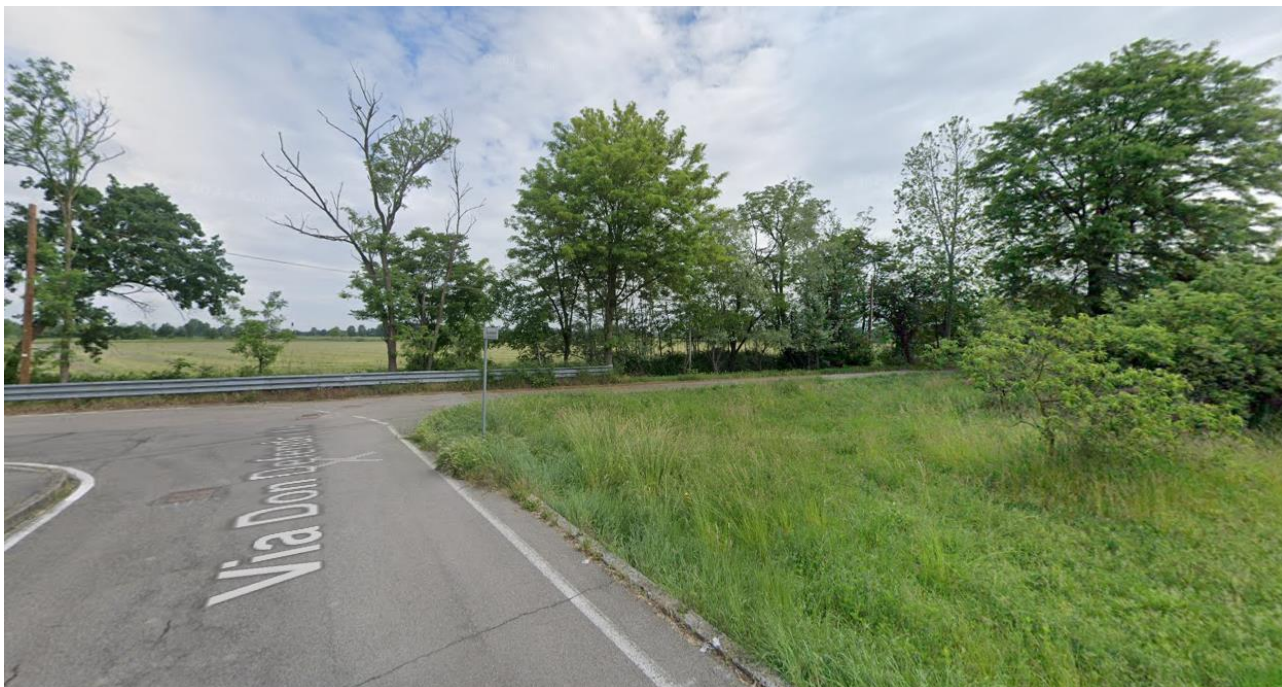
Vista 15 - Vista strada campestre Bettola nella posizione della nuova rampa di accesso
