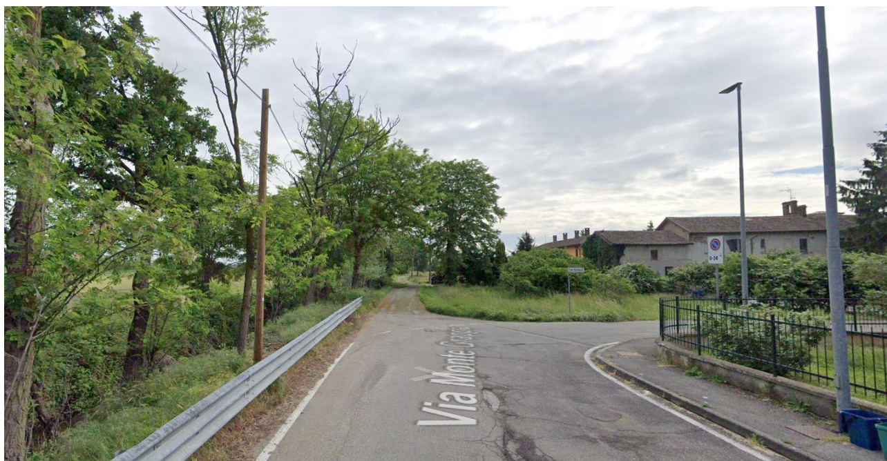
Vista 14 – Vista strada campestre Bettola nella posizione della nuova rampa di accesso
